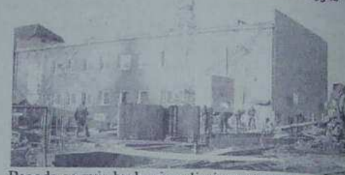
Pogoda sprzyja budowie sali gimnastycznej
